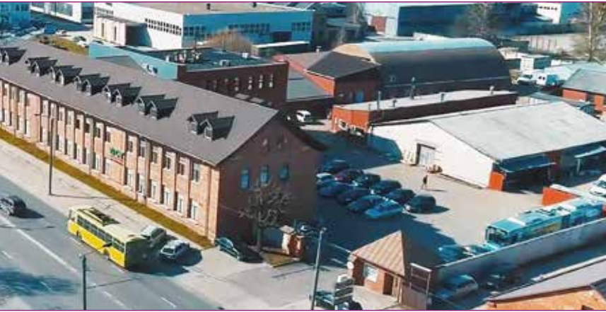
Firmenzentrale von Baltec CNC Technologies in Kaunas
