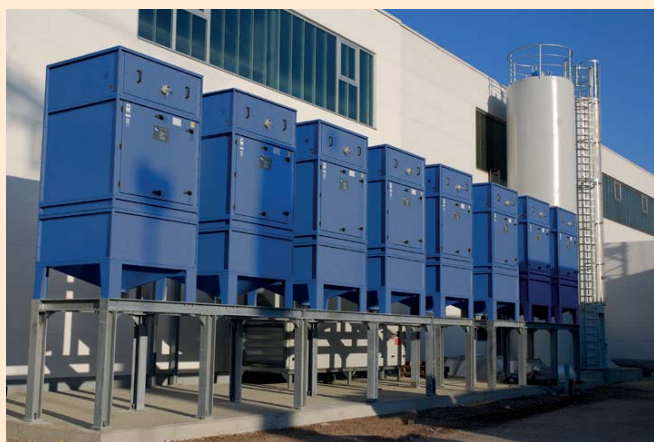
ZPFs modular in Reihe geschaltet mit erhöhter Absaugleistung und Filterfläche
