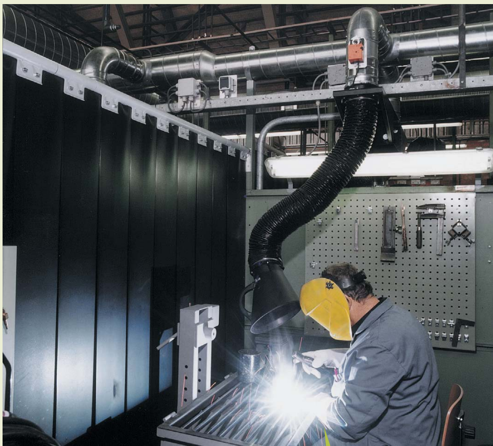
Anwendungsbeispiel: Teleskop-Absaugarm in Schweißkabine
